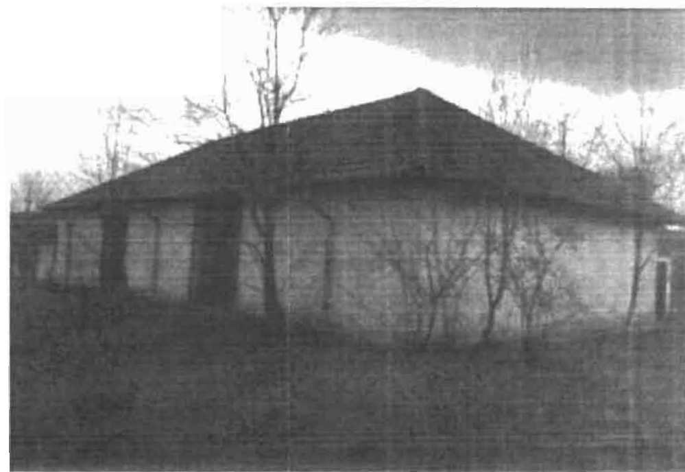
REMIZA și GARAJE - vedere față
