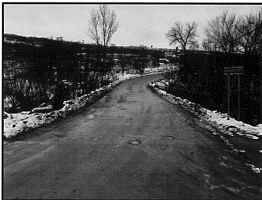
Foto nr. 4 – Alinierea rampa pod defectuoasă, acces dificil pe pod, lipsa parapetului direțional
