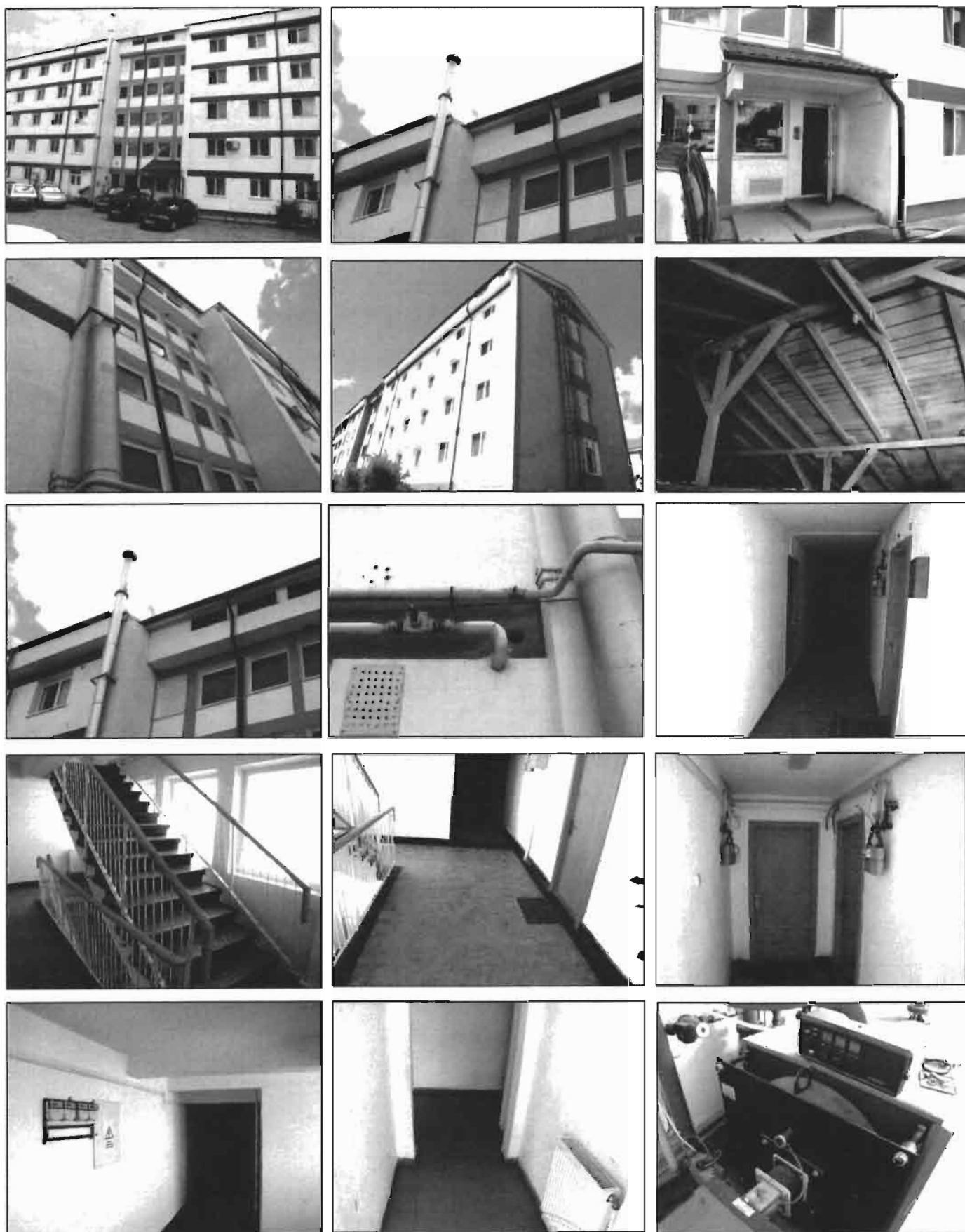
Prezentare foto bloc locuință G1 la exterior și interior
